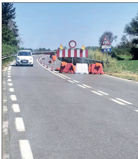
Rampa del "Viadotto Salletto" verso Mantova
